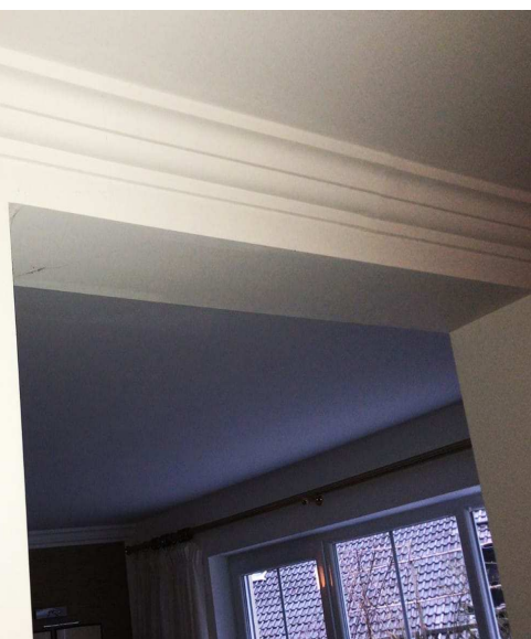
Original italienische Stuckleisten in den Wohnräumen an der Stirnseite
